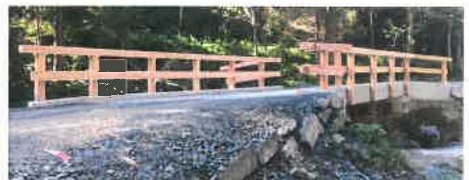
Beispiel für Infrastrukturmaßnahmen ländlicher Raum III Partele-Brünnl-Brücke
