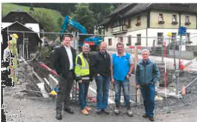
Besichtigung Baustelle Margarethenbach - v.l.: Vbgm. Stampfer, Vbgm. Glatz, Bgm. Stampfer, Baupolier Pontasch und Bauleiter Ing. Jank (WLV)
