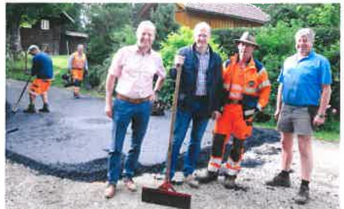
Ortsaugenschein bei den Infrastrukturmaßnahmen durch AL Aigner, Bgm. Stampfer, Baupolier Fa. Swietelsky und Bauhelfer R. Hofer
