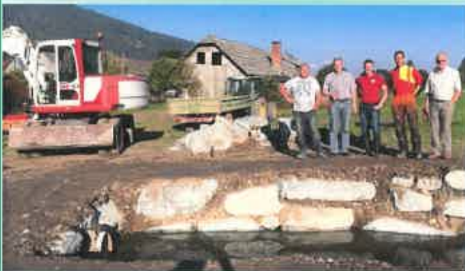
Neuerrichtung Auffangbecken beim Marktl-Bachl
