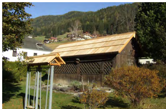
Holzdacheindeckung eines Geräteschuppens
