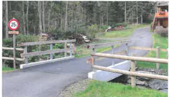
Kronreifbrücke nach der Fertigstellung
