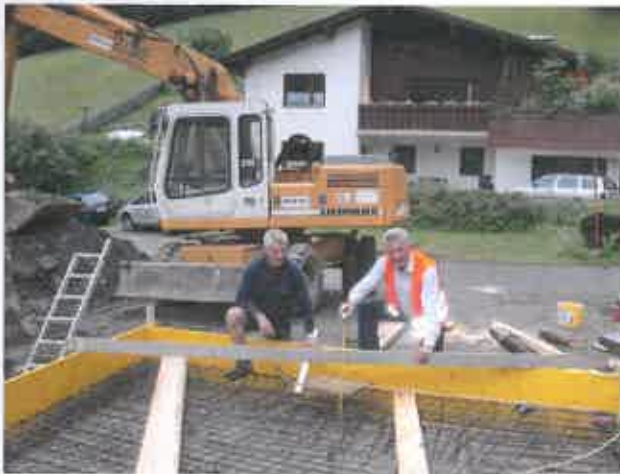
Bauarbeiten bei der Kronreifbrücke
