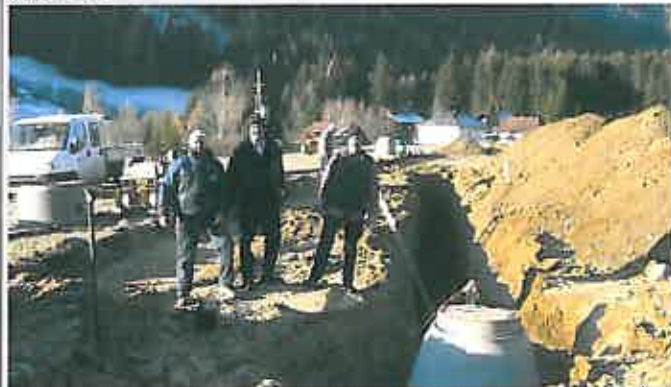
Herstellung der Trinkwasserversorgung und Abwasserentsorgung am Baulandmodell Sonnleitner
