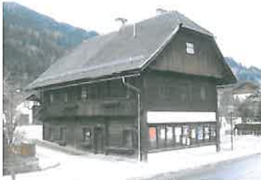
Sanierung? Verkauf? Abbruch mit anschließender Ortsgestaltung?
